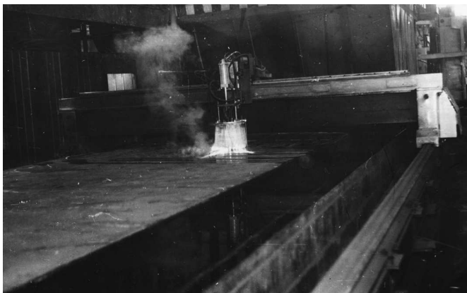
Рис. 4. Портальная машина «Енисей» (ППЛц-2.5) с числовым программным управлением, плазменной оснасткой и защитным устройством
