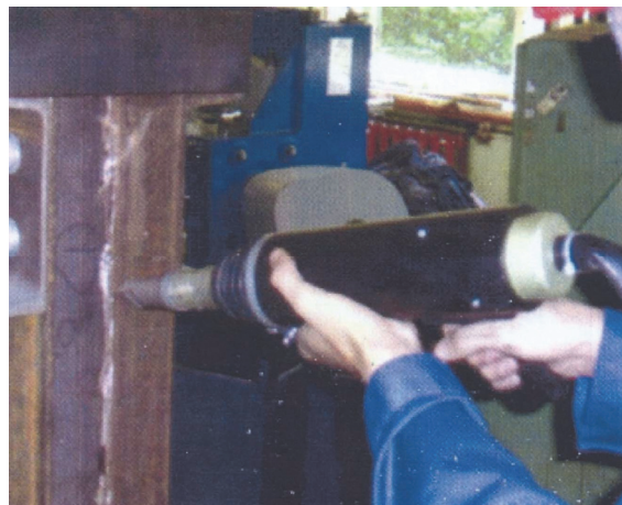
Рис. 3. Фрагмент обработки вертикальной сварной конструкции с помощью установки ИЛ100-16
